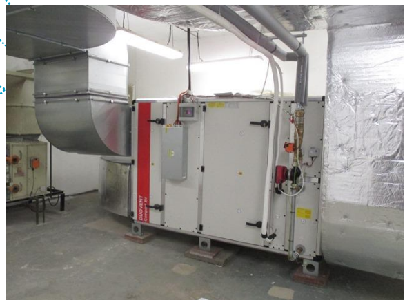
Foto 17 – Rekuperační jednotka pro kuchyň
