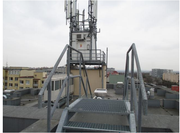
Foto 2 – ÚMČ P14 – Pohled ze střechy domu A (č.p. 1073) na střechu B (č.p. 1072) s telekomunikačním zařízením T-Mobile
