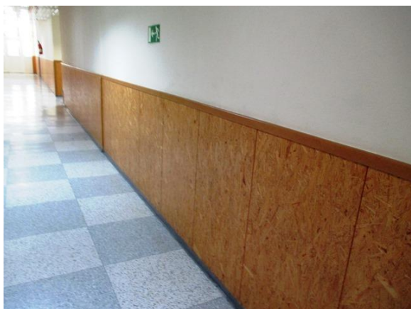
Foto 18 – Obložení chodby na bázi dřevní hmoty
