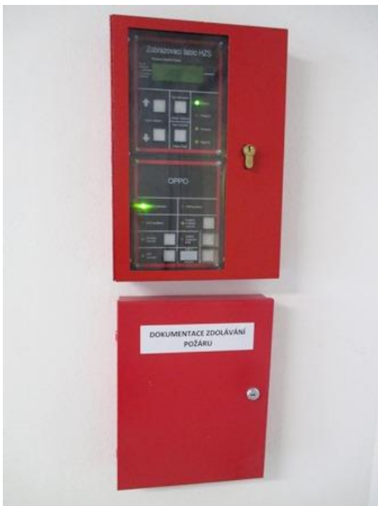
Foto 3 – OPPO (obslužné pole PO) a připravená schránka na DZP.u vrátnice v 1.NP domu A (č.p. 1073)
