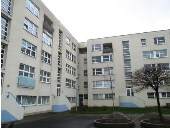
Foto 20 – Jižní roh vnitrobloku – dům č.p. 736 – 742
