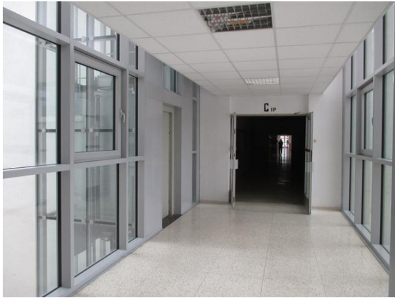
Foto 12 – Spojovací krček mezi pavilony D a C (otevřené požární dveře)
