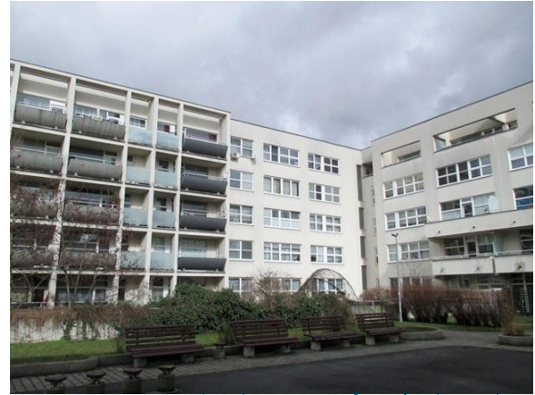
Foto 21 – Severní roh vnitrobloku – dům č.p. 743 – 749
