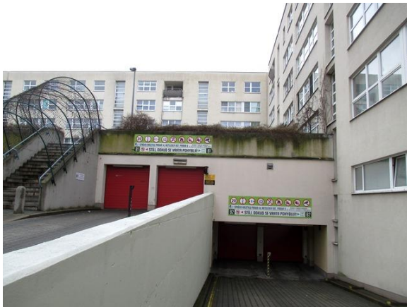
Foto 22 – Vjezdy do dvou podzemních podlaží garáží od ulice Bobkova
