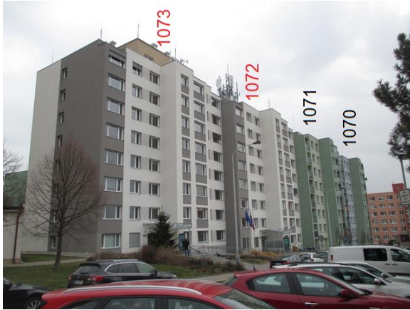
Foto 1 – Blok budov č.p. 1073 a 1072 (domy A a B radnice), č.p. 1071 (byt. dům) a 1070 (byt. dům), z menší části využívaný ÚMČ
