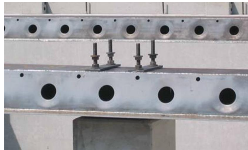
Obrázek 10: Reference uložení komorového nosníku na prefabrikovaný sloup
