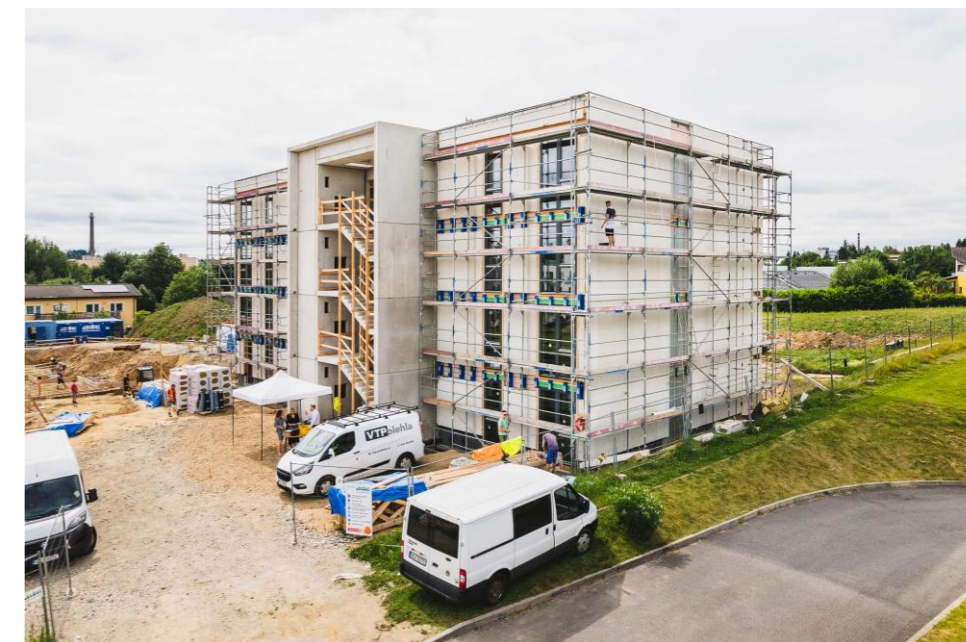
Obrázek 4: Reference 2D modulace CLT panelů včetně TI vrstev
