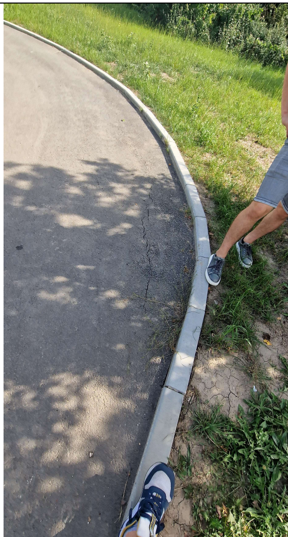
Obrázek 1 – Prasklina ve východní části cyklostezky
