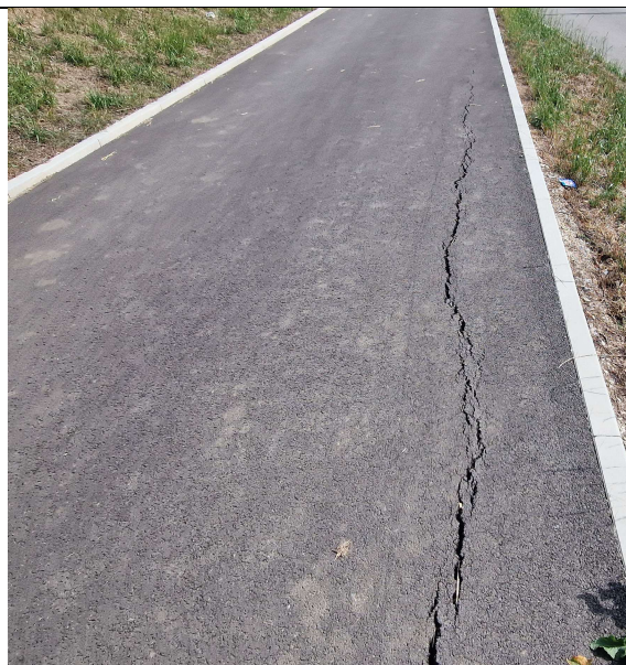
Obrázek 3 – Prasklina u svahu na severozápadě 01
