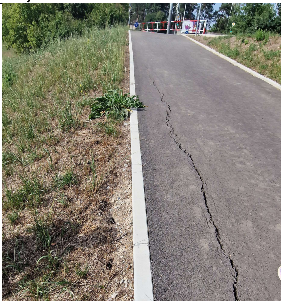
Obrázek 4 – Prasklina u svahu na severozápadě 02
