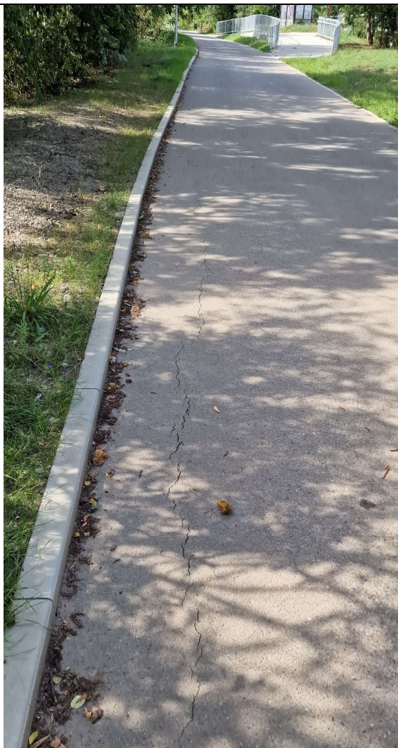
Obrázek 2 – Prasklina východně od provedené HG sondy S6
