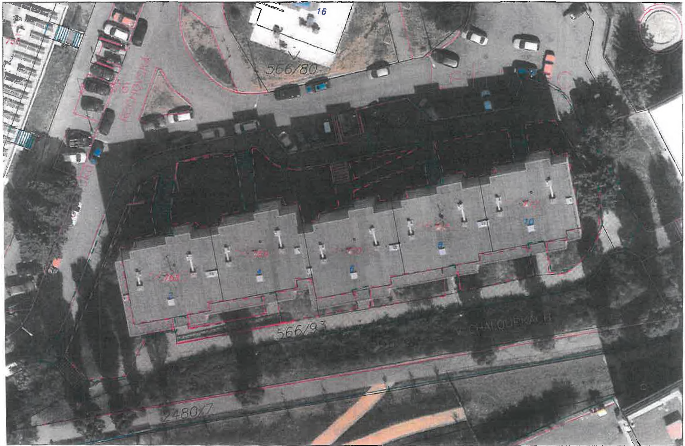
Rochovská 768 – 772, k. ú. Hloubětín
