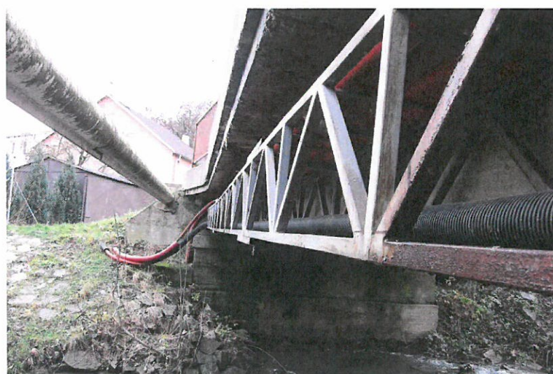
Ocelový příhradový nosník pro převedení kabelů na povodní straně mostu.
