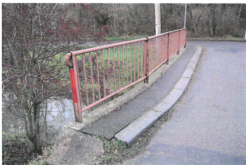
Odrazný proužek se zábradlím na návodní straně mostu.
