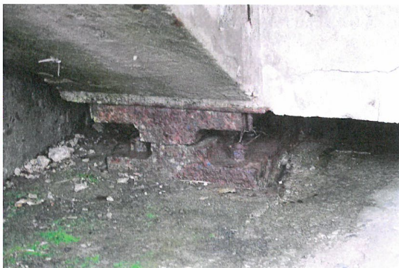
Detail ocelového posuvného ložiska na levobřežní opěře.
