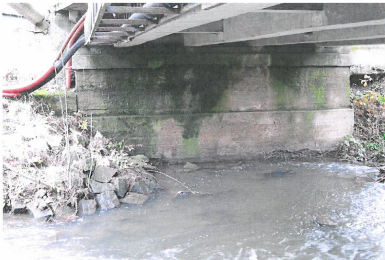
Pohled na pravobřežní opěru.
