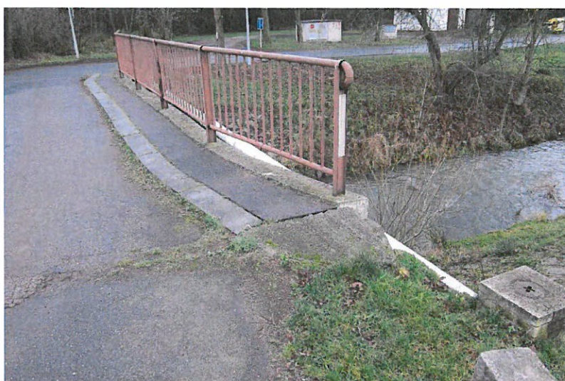
Odrazný proužek se zábradlím na povodní straně mostu.
