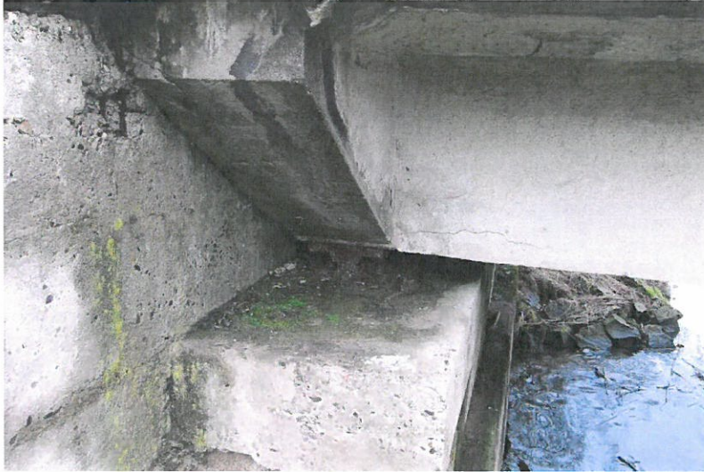
Uložení nk na levobřežní opěře.
