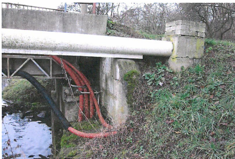
Zaústění inženýrských sítí do terénu na levém břehu.
