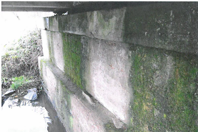
Pohled na levobřežní opěru.
