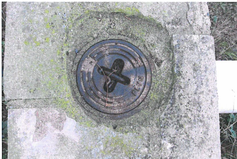
Detail plynové šachty na levém břehu.
