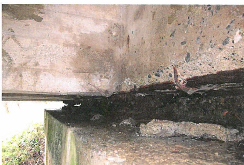
Celkový pohled na úložný práh a příčník na levobřežní opěře.
