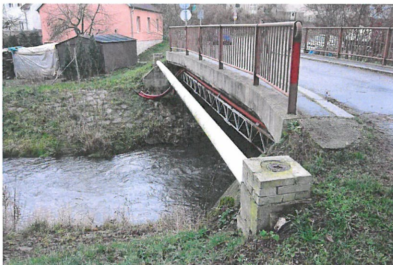
Přechod inženýrských sítí na povodní straně mostu ( 1 x plyn + 5 x kabel ).
