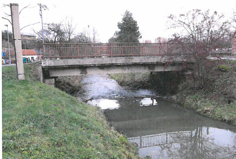
Celkový pohled na návodní stranu mostu.
