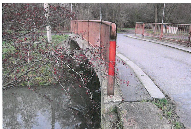
Zábradlí na návodní straně mostu.
