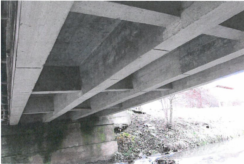
Podhled monolitické železobetonové roštové nosné konstrukce.
