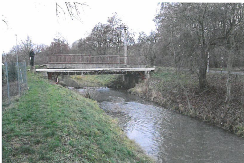
Celkový pohled na most z povodní strany.
