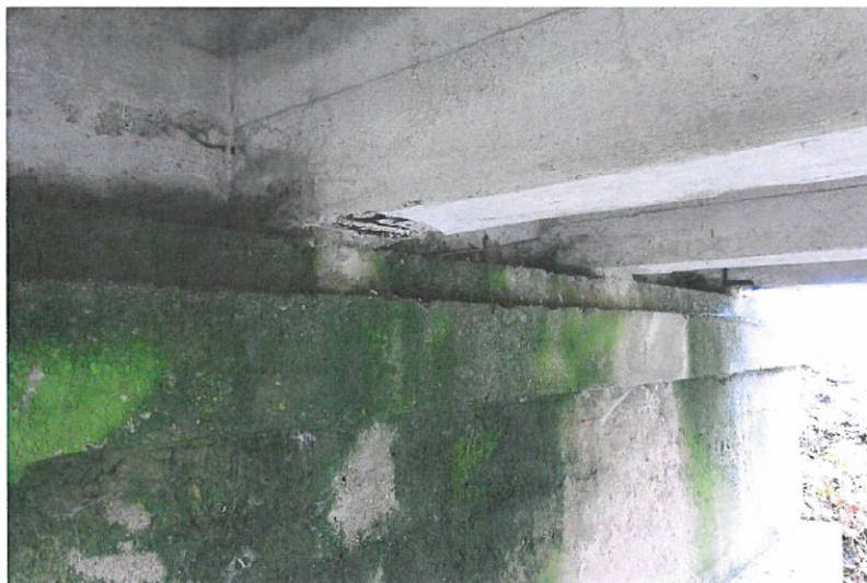
Pevné uložení nk na pravobřežní opěře.
