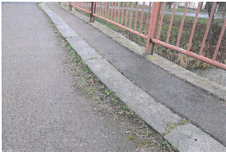
Převrstvená vozovka s nánosy a uchycenou vegetací u obrubníku.
