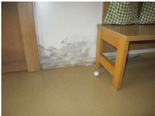
Foto č.11 – poškozené omítky nad podlahami v 1.NP objektu 100b; příčka oddělující hernu a prostory sociálního zázemí
