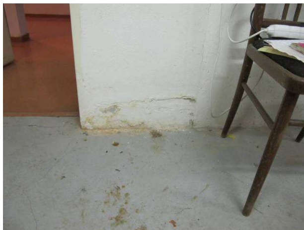
Foto č.10 – začínající degradace omítek v patě stěny vnitřní příčky, na nosné betonové stěně se vlhkostní projevy neobjevují
