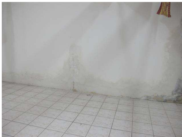
Foto č.2 – výrazná vlhkostní mapa na obvodové stěně s navýšením úrovně v další pracovní spáře
