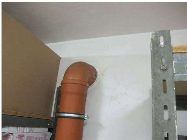
Foto č.5 – sprašování maleb okolo kanalizačního potrubí
