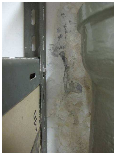
Foto č.8 – detail hloubkové destrukce omítek v místě pracovní spáry
