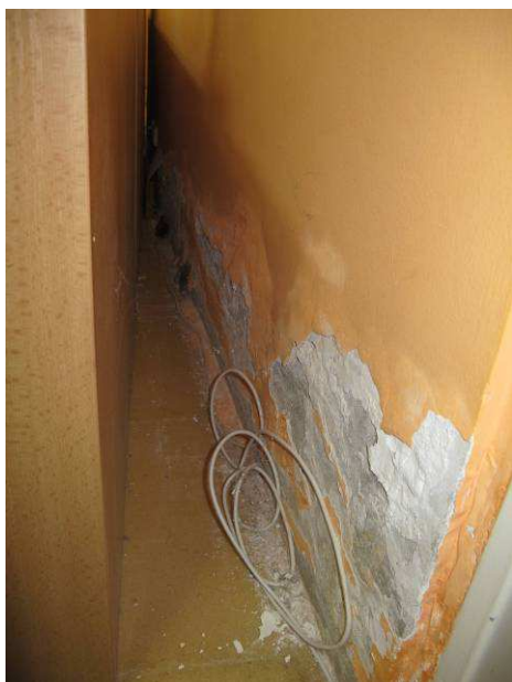
Foto č.13 – poškozené omítky nad podlahami v 1.NP objektu 100b; příčka oddělující hernu a prostory sociálního zázemí
