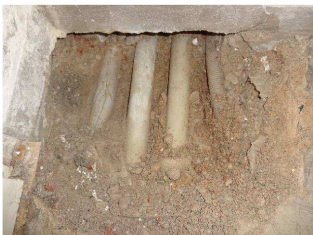
Foto č.15 – detail sondy; výrazné zvlhčení celého podlahového souvrství
