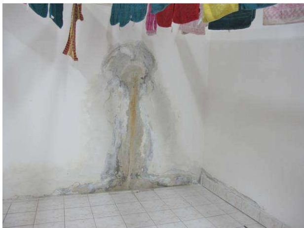
Foto č.1 – místo s nejvýraznějším protékáním (místo odběru vzorku V1)
