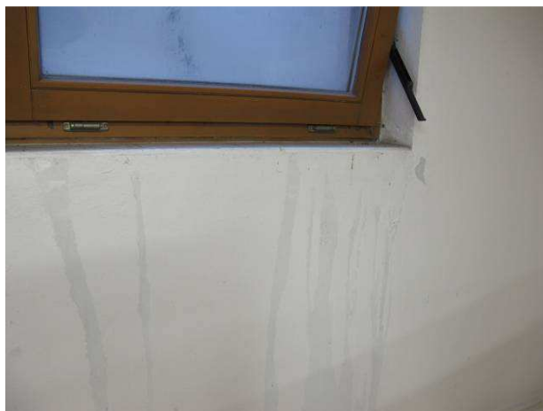
Foto č.4 – vytékání srážkové vody z prostoru anglického dvorku s nefunkčním (zaneseným) odtokovým kanálkem; tento problém je u všech oken v 1.PP
