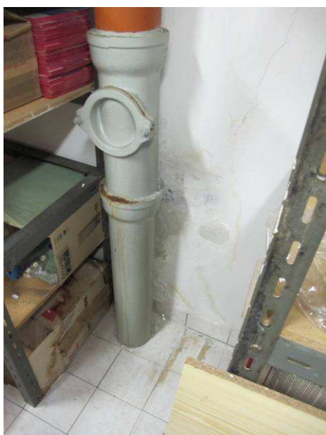
Foto č.7 – celkový pohled na rozsah poškozených omítek
