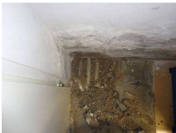
Foto č.14 – provedená sonda v zádveři skladu hraček a rekvizit
