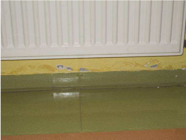
Foto č.17 – vlhkostní mapy se začínající degradací omítek pod topením na obvodové stěně u balkonové desky
