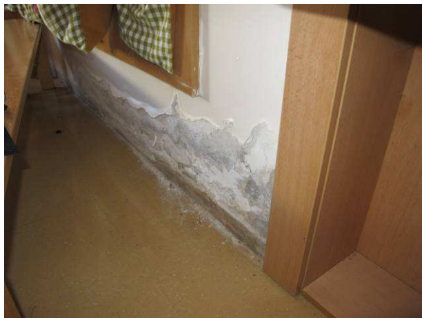
Foto č.12 – poškozené omítky nad podlahami v 1.NP objektu 100b; příčka oddělující hernu a prostory sociálního zázemí
